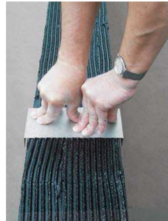
Wklejenie blachy kompensacyjnej
