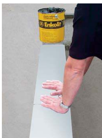
Równomierne dociśnięcie obróbki blacharskiej
