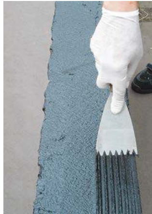
Rozprowadzenie Enkolit szpachlą zębatą
