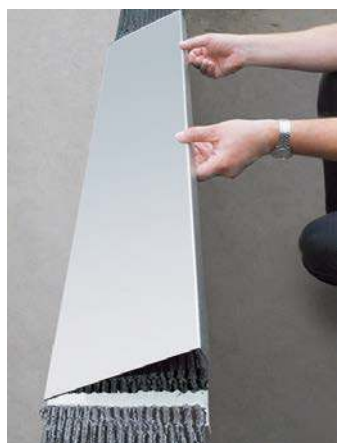
Umieszczenie obróbki blacharskiej
