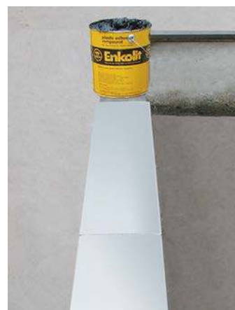
Przyklejona obróbka blacharska
